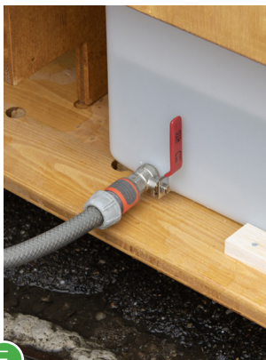
E Raccorder le tuyau au réservoir d'urine à l'aide de l'adaptateur Gardena.
