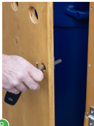
B Ouvrir le compartiment d'entretien avec la clé et ouvrir le clapet pour le réservoir d'urine.
