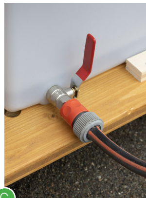
C Raccorder le tuyau au réservoir d'urine à l'aide de l'adaptateur Gardena.
