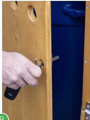
B Wartungsraum aufschliessen und Klappe für den Urintank öffnen.
