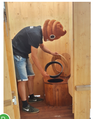
B Schutzring entfernen.
